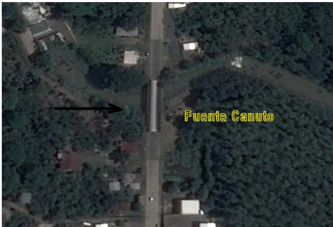
IMAGEN SATELITAL DEL PUENTE ACTUAL
