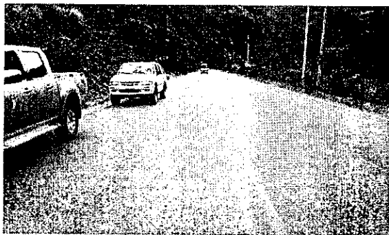
Falta de Señalización Vial
