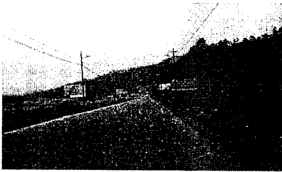
Falta de Señalización Vial
