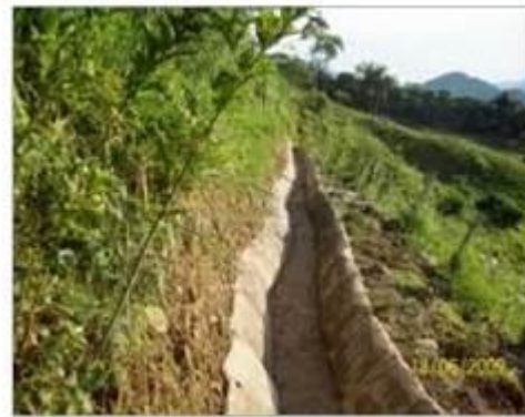
INSTALACION SACOS / SUELO CEMENTO
