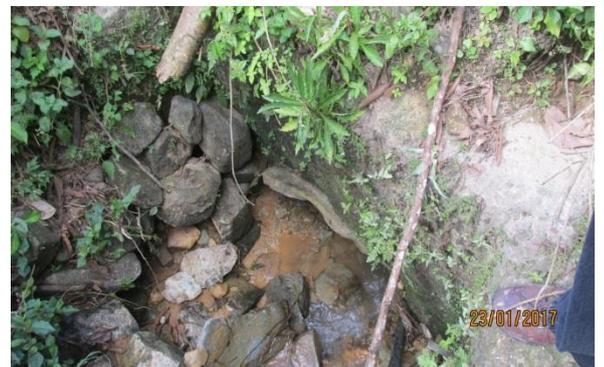
En este sitio se observa casi desestabilizada toda la calzada con grandes grietas y asentamientos que sobrepasa los 0.40 m, se tiene una alcantarilla totalmente azolvada en la abscisa 67+420, que no permite el drenaje de las aguas lluvias que produce esta micro cuenca.
