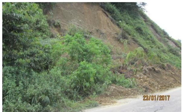
Debido al deslizamiento de la margen izquierda de la vía, se ha perdido casi la totalidad del ancho de la calzada, observándose grandes fisuras y
