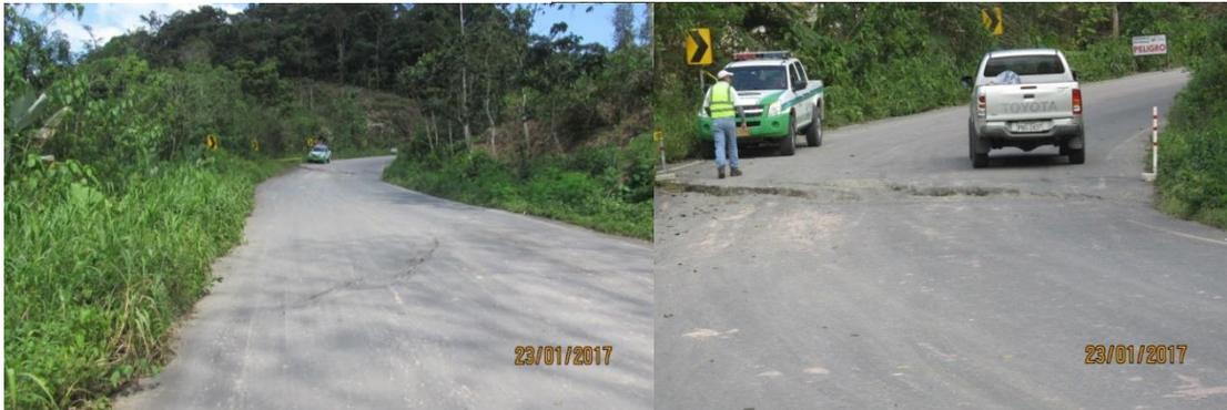
Se observa un asentamiento muy peligroso para la circulación vehicular, en aproximadamente una longitud de 55.00 m y todo el ancho de la vía en un ancho aproximado de 10.00 m, se debe reponer las cunetas en ambos lados de la vía.
