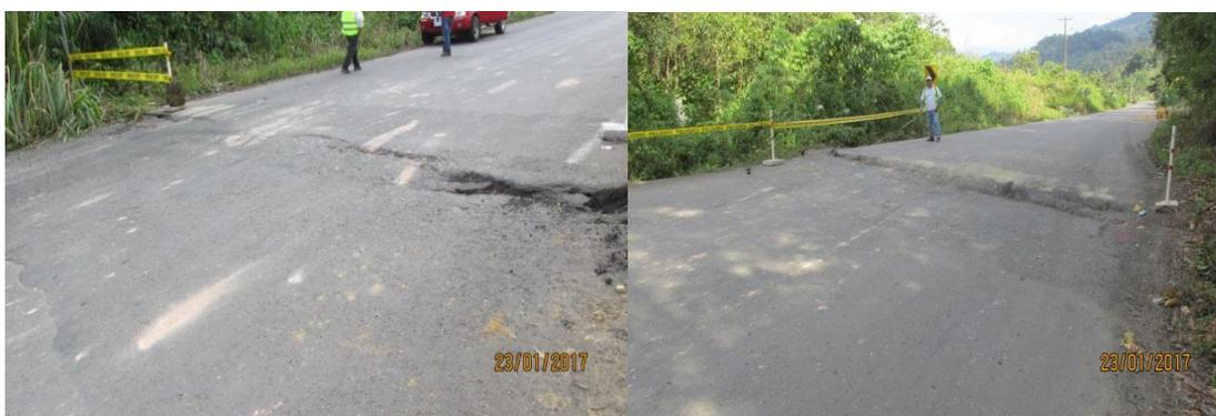
Se observa asentamiento o falla geológica en un tramo aproximado de 45.00m de longitud y todo el ancho de la calzada de 11.00m
