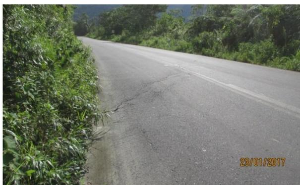
Se observa asentamiento o falla geológica en un tramo aproximado de 20.00m de longitud y todo el ancho de la calzada de 11.00m, Se debe realizar el mantenimiento de la alcantarilla.
