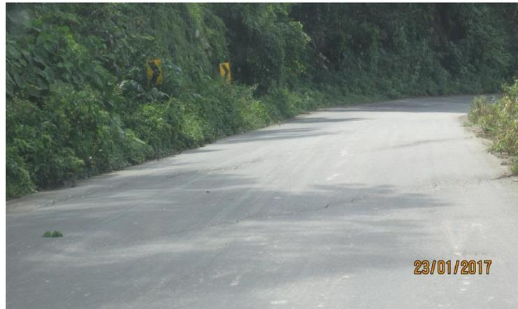
Se observa asentamiento en todo el ancho de la vía, en una longitud de 40.00 m y de 10.00 m de ancho, se tiene asentamiento de la alcantarilla, por lo que es necesaria su reposición.
