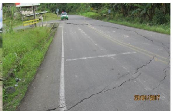
Se observa asentamiento en todo el ancho de la calzada, con grandes grietas que pone en peligro la circulación vehicular en esta vía, existe asentamiento de la alcantarilla. La longitud del asentamiento es de 35.00m de largo y 11.00m de ancho.
