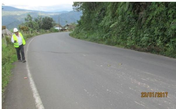
Se observa asentamiento o falla geológica en un tramo aproximado de 20.00m de longitud y todo el ancho de la calzada de 11.00m. Se debe realizar el cambio de la alcantarilla.
