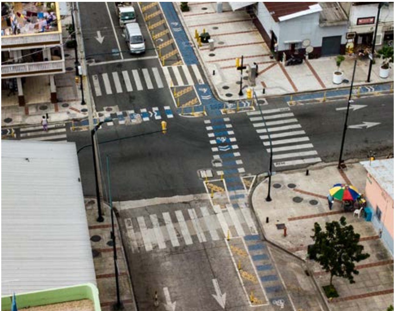
IMAGEN 20. Diseño de intersección segura Calles Ismel Perez Pazmiño y 10 de Agosto, Guayaquil. Diseño elaborado por el Departamento de Planificación de la Movilidad en donde se tomaron en consideración los elementos arriba mencionados de intersección segura, ATM. Fuente. DATM Guayaquil
