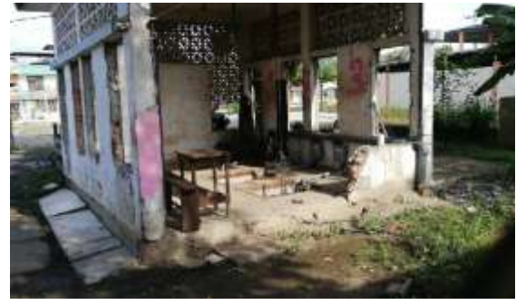
Ilustración 2 Infraestructura de caseta de bombeo existente.
