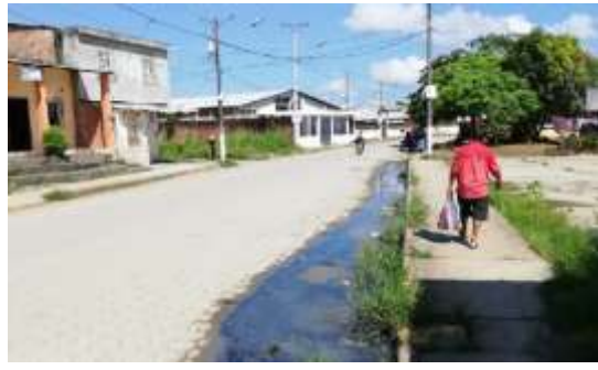
Ilustración 1 Punto de Rebose en Av. 10 de Agosto y Calle 6.
