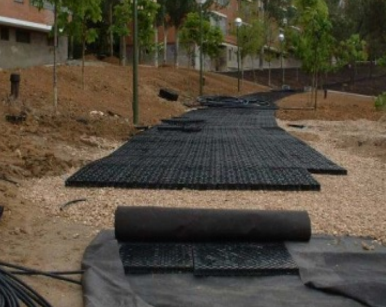
Ilustración 18: Instalación del drenaje sostenible y resultado final. Fuente: Drenaje Sostenible
