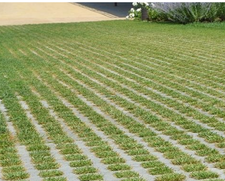
Ilustración 19: Pavimento drenante para evitar inundaciones. Fuente: Parque Benicalap, Valencia / Téseris, España
