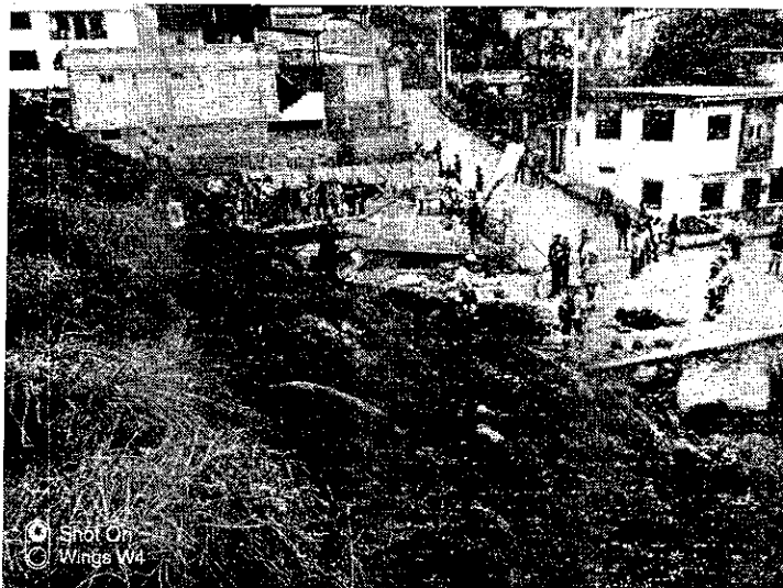
Identificación de viviendas destruidas. Se observa al personal de Cuerpo de Bomberos en tareas de búsqueda y rescate.
