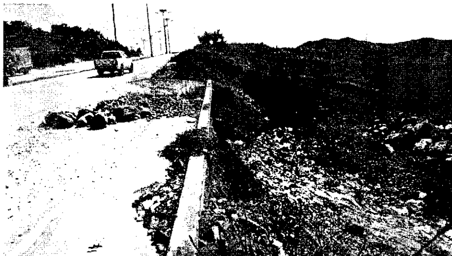
PUNTO CRÍTICO - PERDIDA DE LA ESTRUCTURA VIAL
