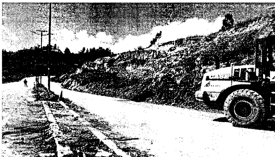
MANTENIMIENTO DE LA VÍA REALIZADO POR LA DIRECCIÓN PROVINCIAL DE LOJA
