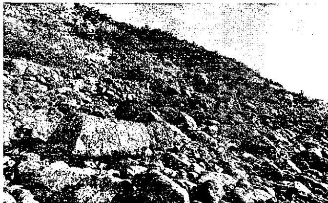
Foto 1. Muro de Escollera en proceso de destrucción que deberá ser reconstruido
