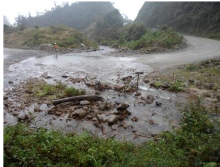
Figura 1 SITUACIÓN ACTUAL PUENTE QDA. HONDA
