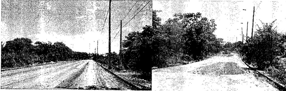
El Gad está colocando tierra del sector, tapando los baches y huecos para mejorar la circulación; su durabilidad es relativa, depende del tráfico y la presencia de la lluvia.
