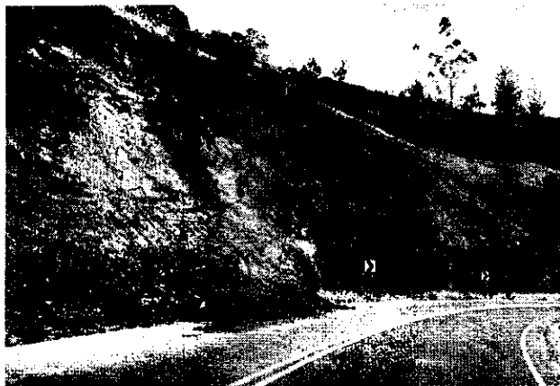
En la abscisa 6+200, se puede observar un derrumbe de magnitud menor, pero que obstaculiza la libre circulación del agua por la cuneta.
