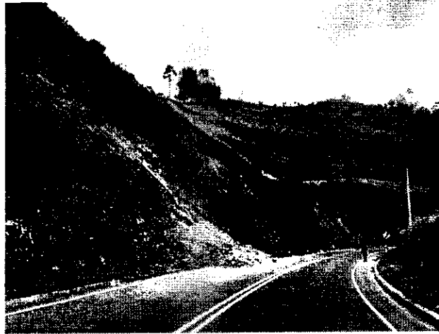
En la abscisa 6+200, se puede observar un derrumbe de magnitud menor, pero que obstaculiza la libre circulación del agua por la cuneta.
