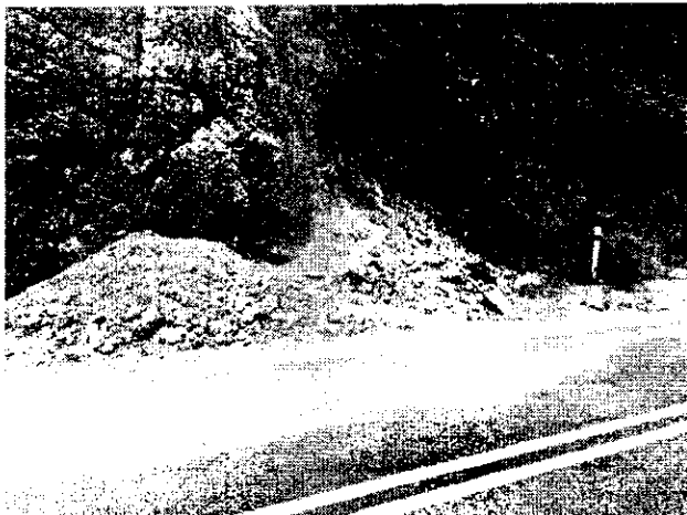
En la abscisa 8+200, se puede observar un derrumbe de magnitud menor, pero que obstaculiza la libre circulación del agua por la cuneta.
