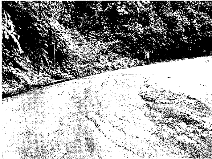
Deficiencia de Drenaje, falta de mantenimiento, presencia de ahuellamientos y baches
