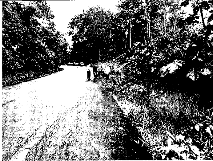
Sitio Crítico, presencia de fisuramiento y hundimientos, el borde de la vía esta erosionado
