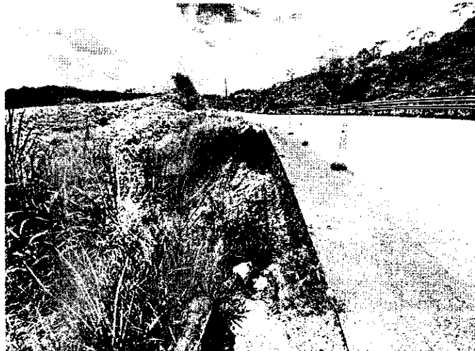
Sito Crítico, parte de la estructura de vía colapsada
