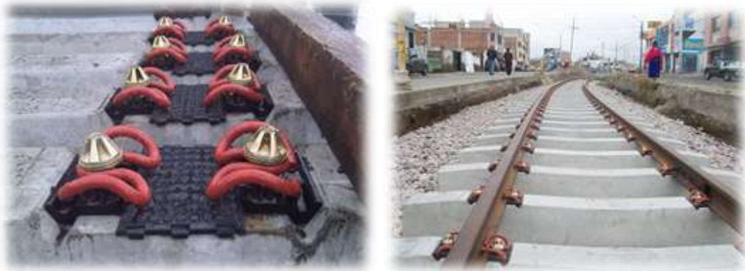
Fig. Sujeciones durmientes de Hormigón
