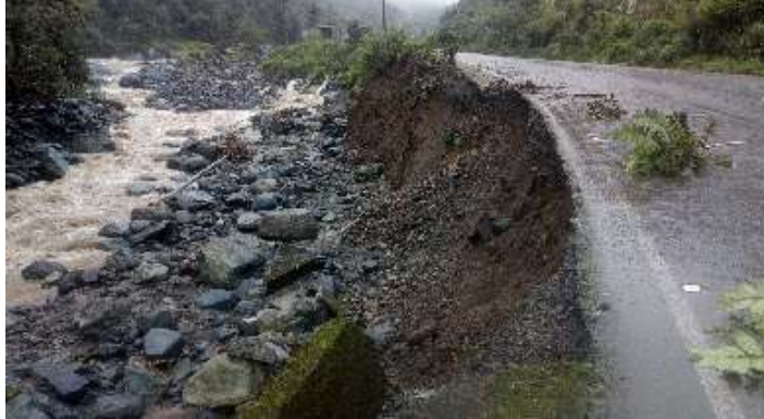
Ilustración 23 Primer sub-tramo de reconstrucción; Absc. 105+00
