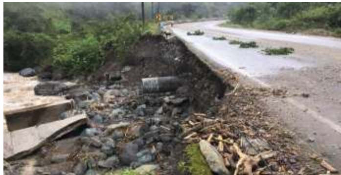
Ilustración 22 Creciente del río Pilaló ocasionó daños de consideración en la vía; Absc. 100+00
