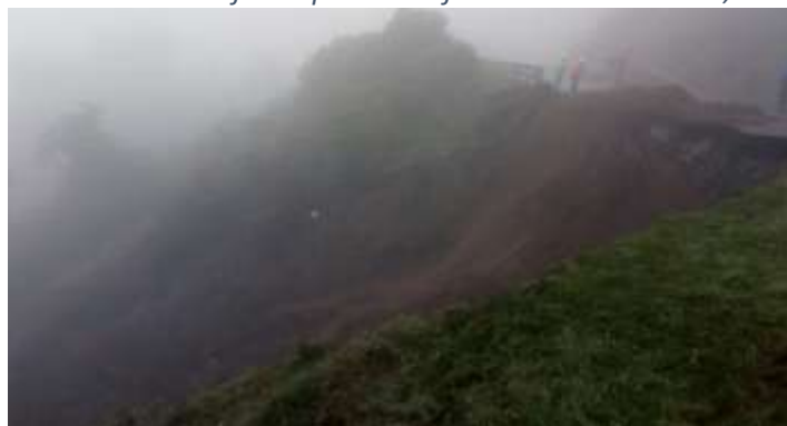
Ilustración 12 Deslizamiento de talud inferior produce afectación sobre la vía; Absc. 80+500-
