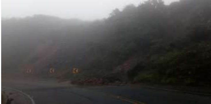
Ilustración 9 Deslizamiento sobre una longitud de 60m y una altura del talud alrededor de 20m. Absc. 75+500.
