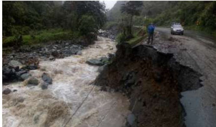
Ilustración 24 Segundo sub-tramo de reconstrucción; Absc. 105+00
