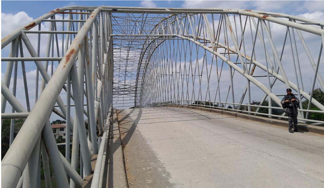
Foto 4. Elementos estructurales parte superior.
