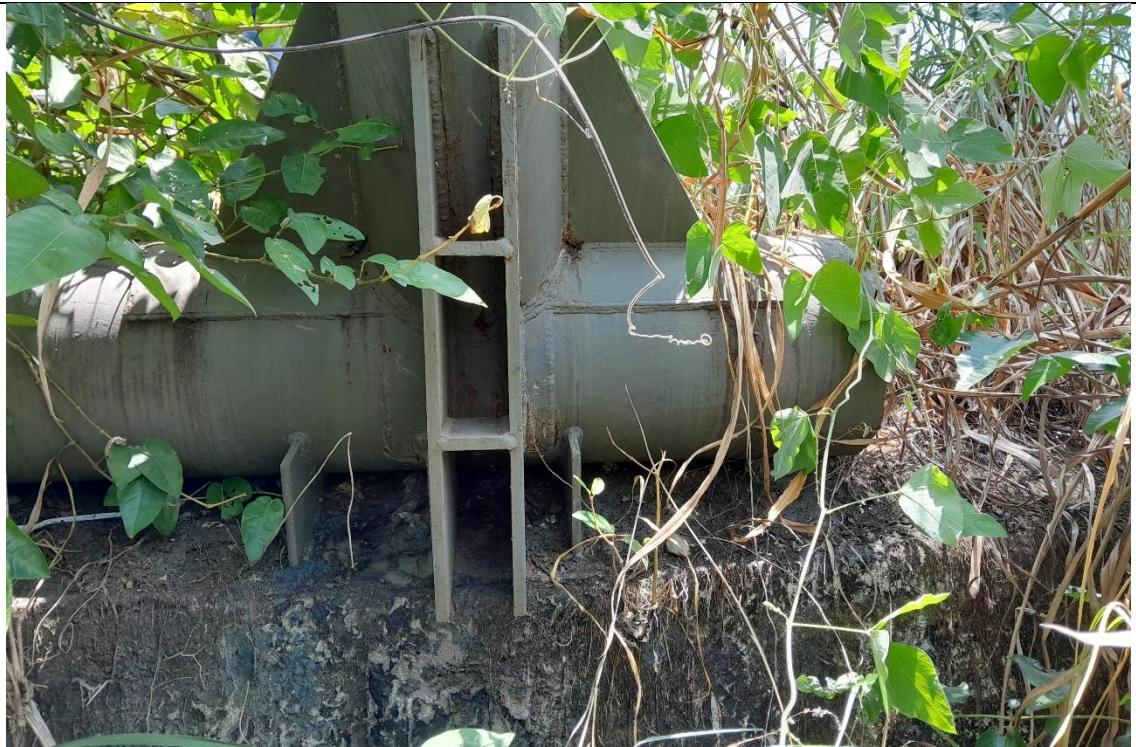
Foto 2. Típica Soldadura de filete en bases del puente, placas, rigidizadores.
