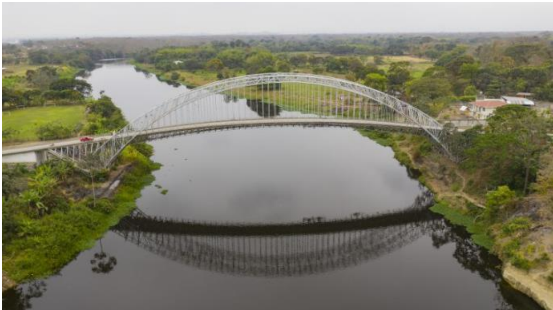
Foto 1. Puente de BALZAR, objeto de inspección
