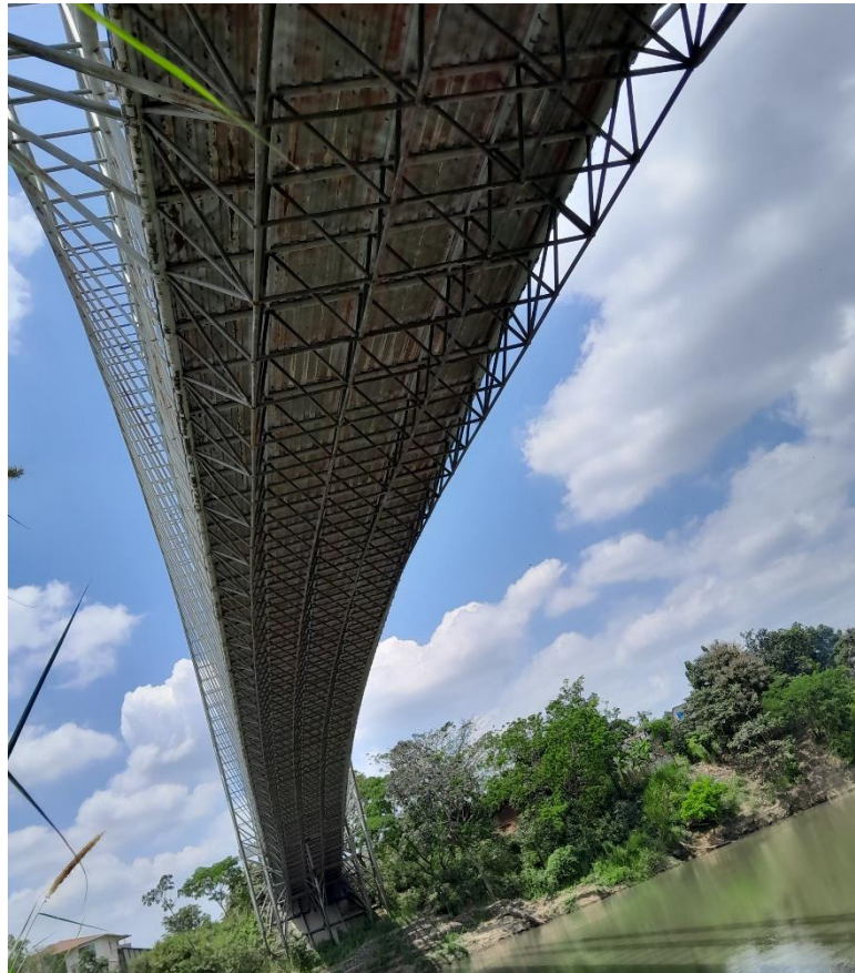
Foto 3. Elementos estructurales parte inferior.
