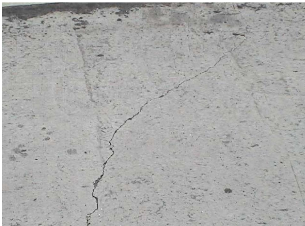
Fotografía 07: Fisuras diagonales
