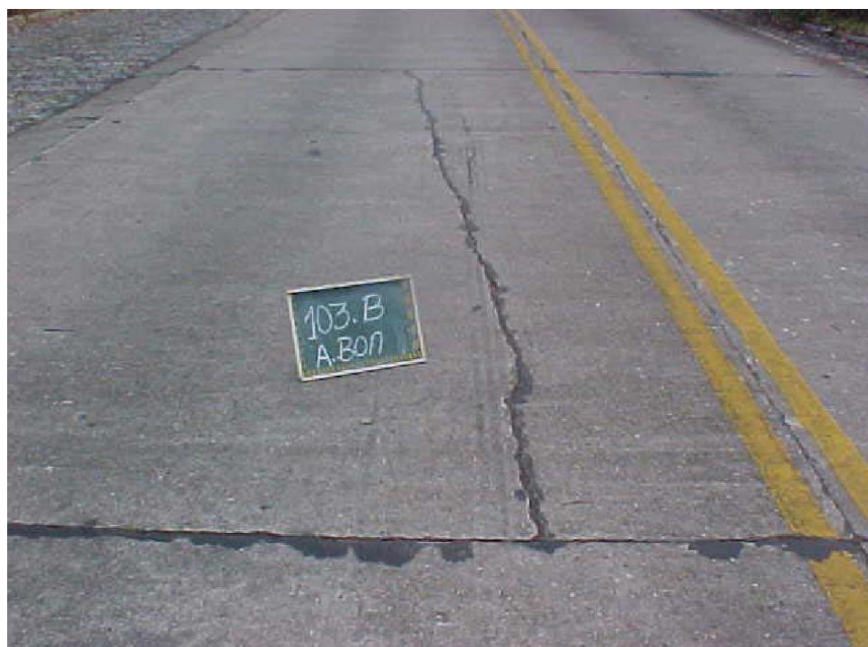
Fotografía 06: Fisuras longitudinales
