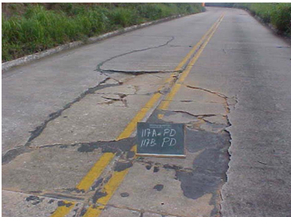
Fotografía 03: Losa dividida
