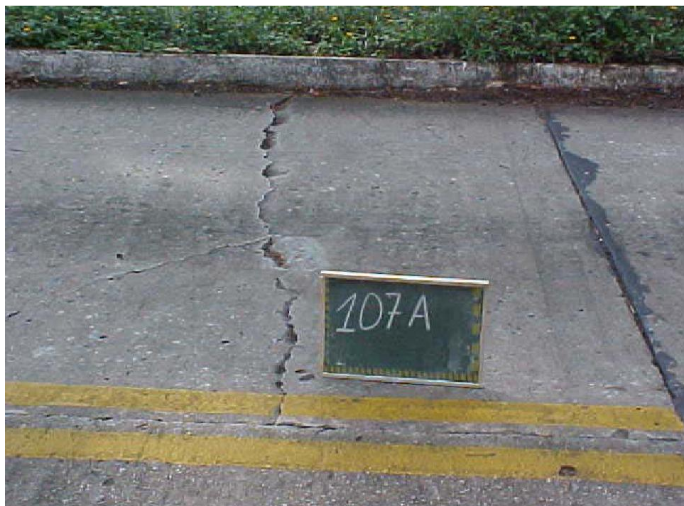
Fotografía 05: Fisuras Transversales
