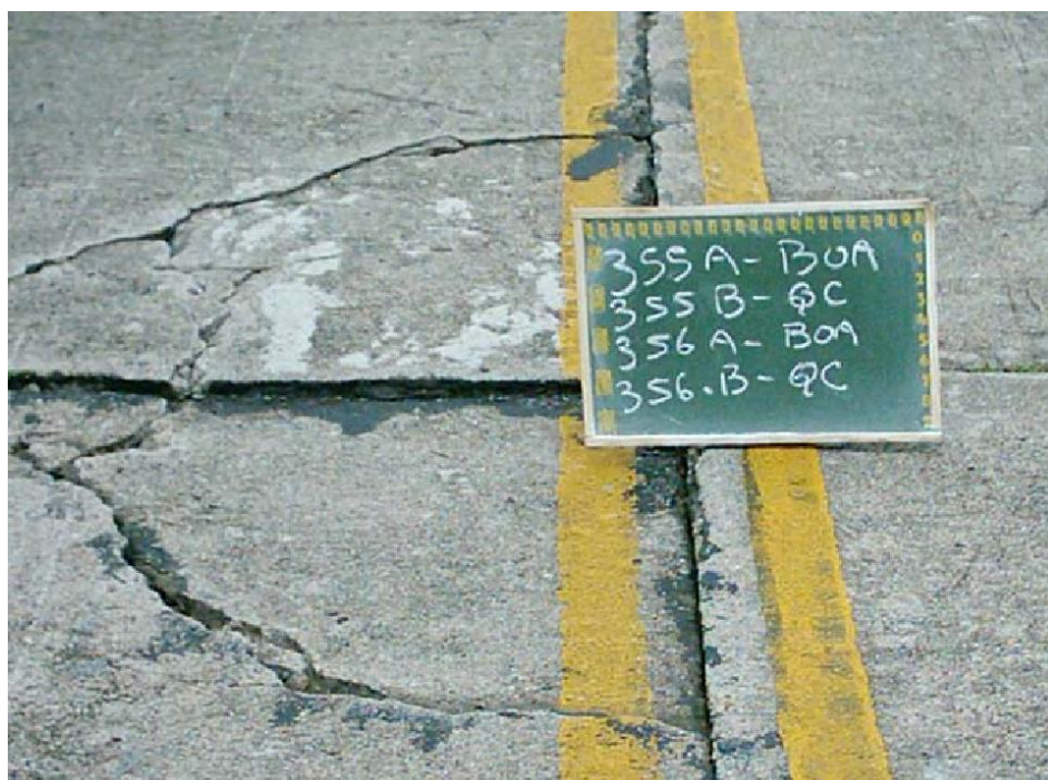
Fotografía 12: Roturas localizadas
