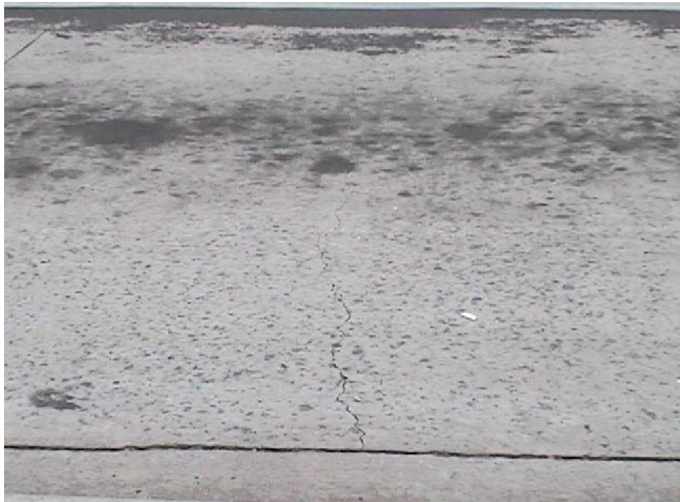
Fotografía 10: Desgaste superficial
