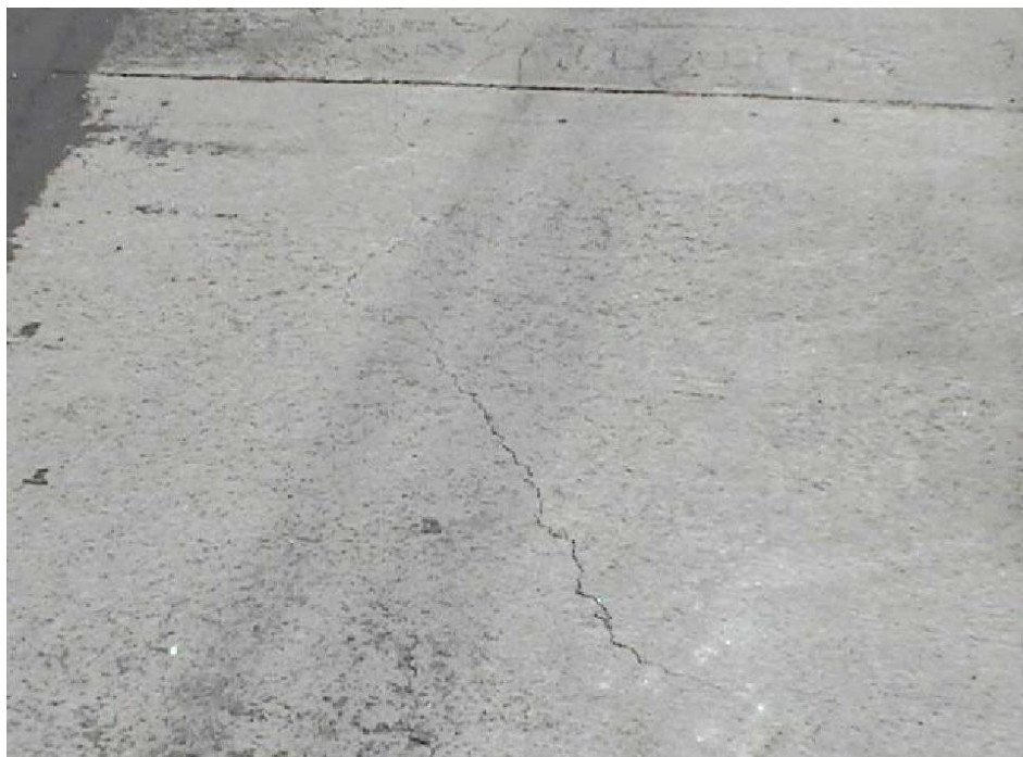
Fotografía 11: Fisuras superficiales
