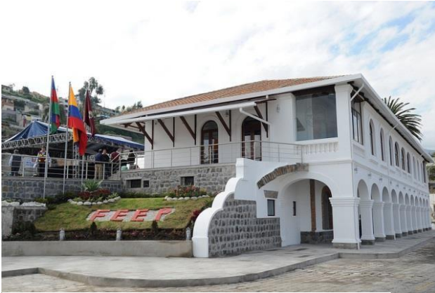
Fachada estación Otavalo
