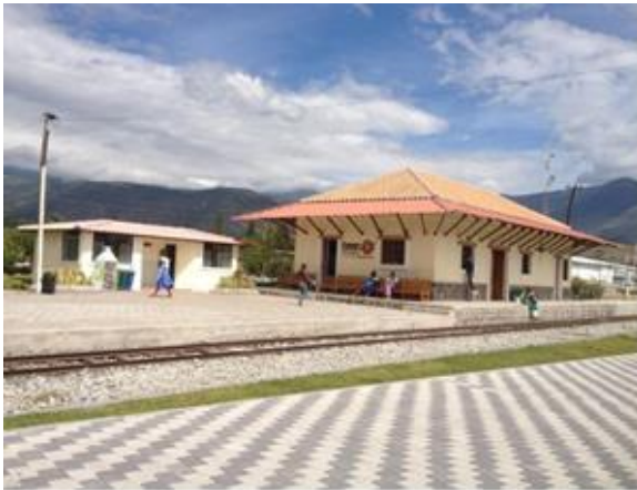
Vista general de la estación y plaza
