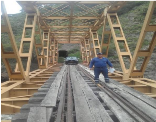
Puente con estructura metálica
