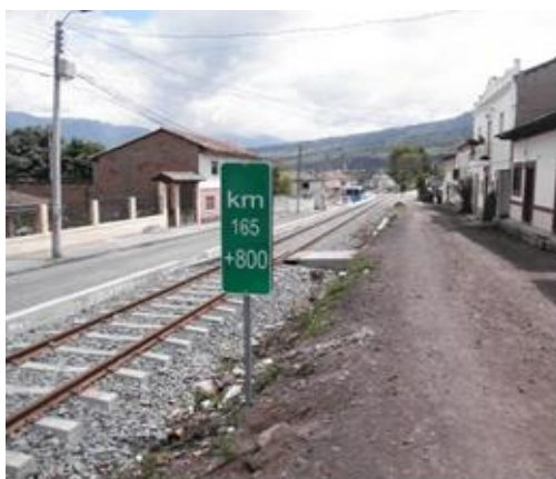
Vía férrea en zona urbana consolidada
