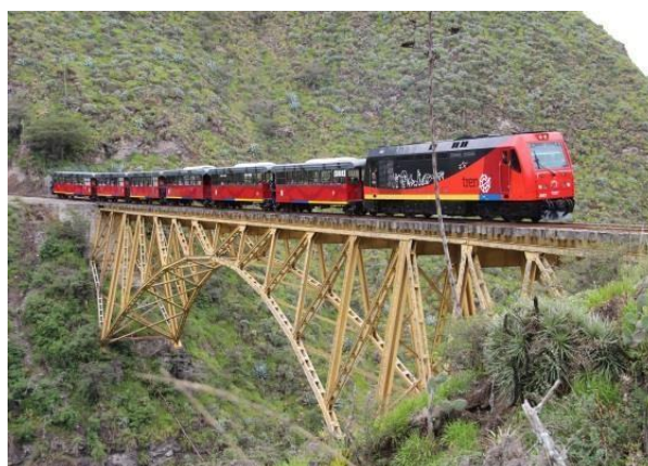
Locomotora sobre puente Ambi
