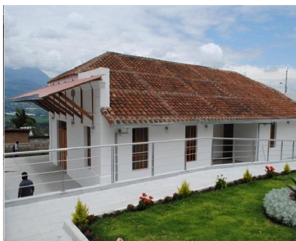
Fachada estación San Roque
