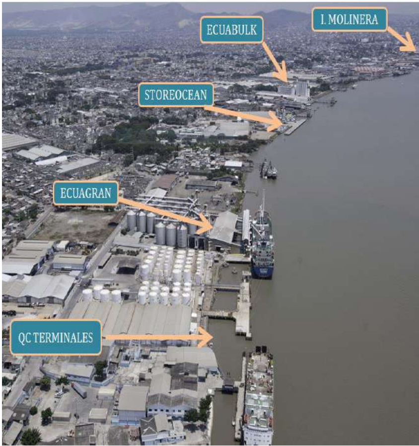
Terminales en el Río Guayas de Graneles Líquidos y Sólidos y Cabotaje a Galápagos
